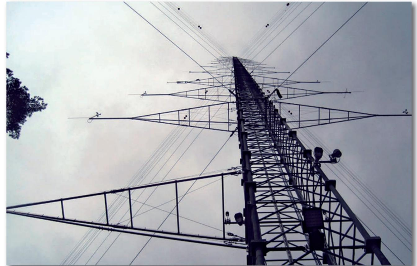
In Wolfhagen bei Kassel entstand für das Fraunhofer IWES der mit 200 m höchste Windmessmast Europas. Gemeinsam mit seinem schwedischen Partner für den Mastbau TELECON und dem akkreditierten Prüflaboratorium WINDTEST GREVENBROICH realisierte Wilmers Messtechnik dieses anspruchsvolle Projekt.
