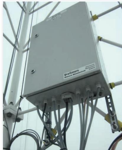
Speziell entwickelte Mastboxen wurden von unseren Kletterern in 85 m, 145 m und 185 m montiert.
