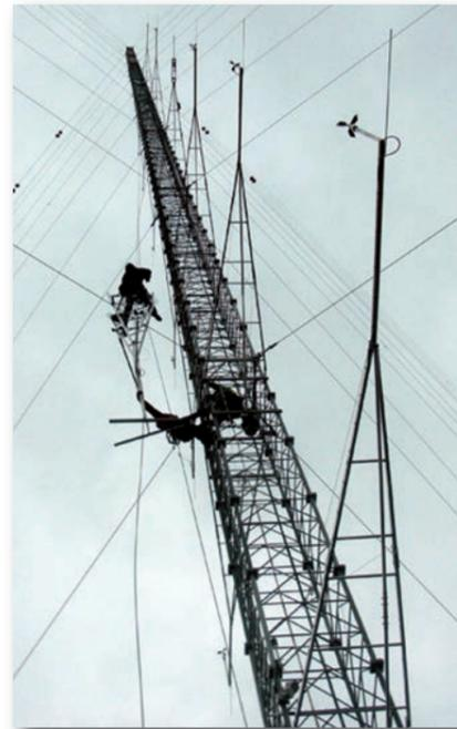
Die Sensorausleger wurden von unseren speziell ausgebildeten Kletterern angebracht – der höchste in 200 m.
