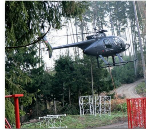
Für die Montage ab 120 m kam ein Hubschrauber zum Einsatz.
