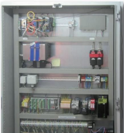
Sämtliche Messdaten werden von Wilmers Datenloggern erfasst. Die Messstation ist über das Internet erreichbar.
